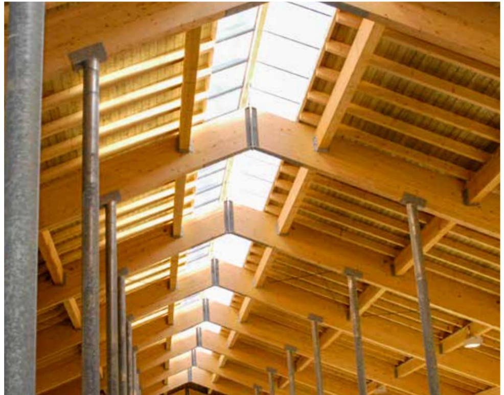
Valg av trematerialer fremfor stål, plast og betong reduserer klimabelastningen. Lysmøne sparer energi til belysning. Foto: Rasmus Lang-Ree
