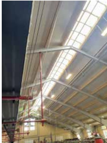
Lysmøne og ledlys sparer mye energi til belysning i et fjøs.
